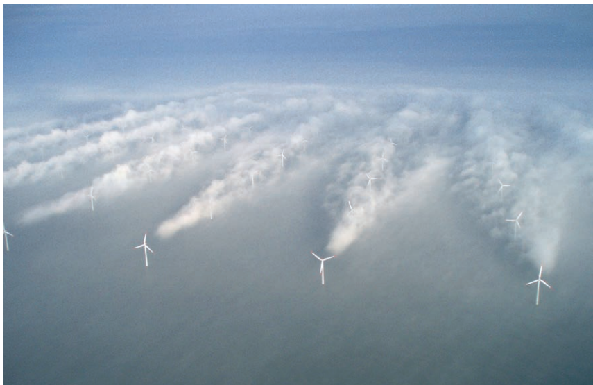
Farma wiatraków Vattenfall w Horns 2, Dania. Moc zainstalowana 70 MW, użyteczna 25 MW
