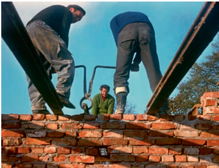
Szyny kolejowe Kruppa na naszym stropie
