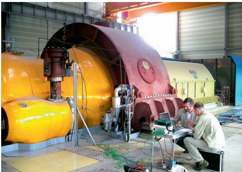
Doktor Dariusz Obrzut na pomiarach turbinowych
