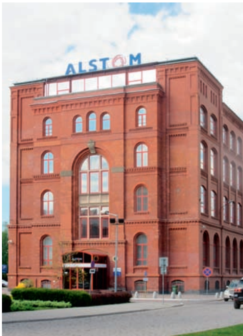
Budynek biura konstrukcyjnego fabryki turbin w Elblągu po renowacji
