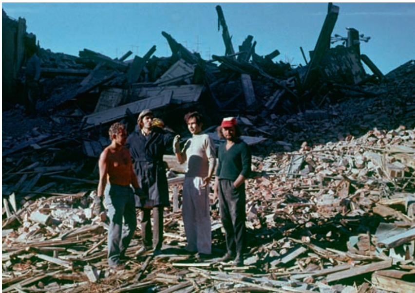
Rozbiórka byłego budynku Milicji Obywatelskiej we Wrzeszcu. Obecnie to teren centrum Manhattan
