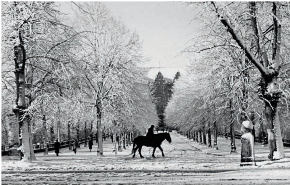
Konny Trakt, w głębi gmach główny Politechniki Gdańskiej, 1956
