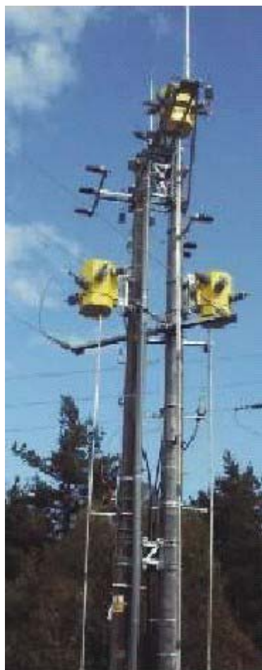
Rys. 3.41. Widok słupa z zainstalowanymi rozłącznikami THO/T i samego rozłącznika
