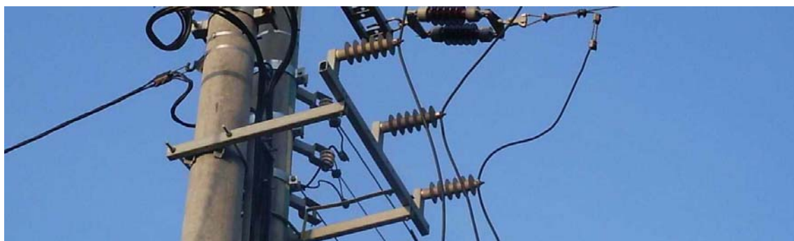
Rys. 3.36. Belka nośna podstaw bezpiecznikowych SN
