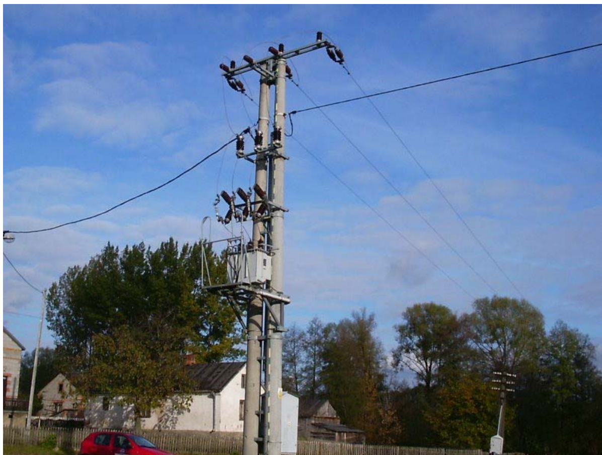
Rys. 3.34. Stacja transformatorowa słupowa STSR-20/400-12/12/II
