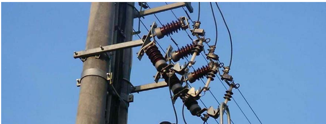
Rys. 3.36. Belka nośna podstaw bezpiecznikowych SN
