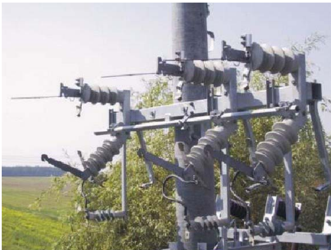
Rys. 3.43. Widok odłącznika modułowego
