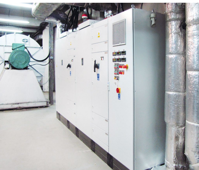
Rozdzielnica z kaskadą dwóch napędów 400 kW
