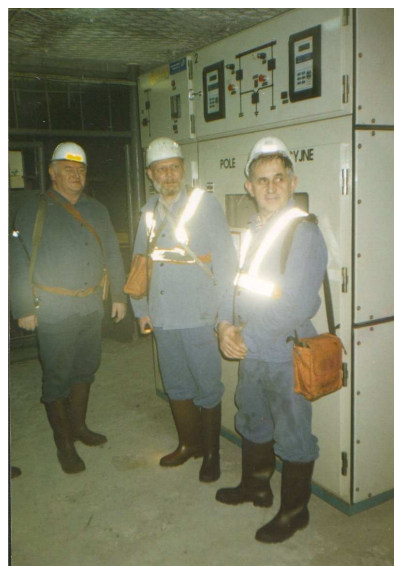
Fot. 4. Automatycznie regulowana bateria BSCR-3 6,3kV dopuszczona do podziemi kopalń. Produkcja ELMA energia
