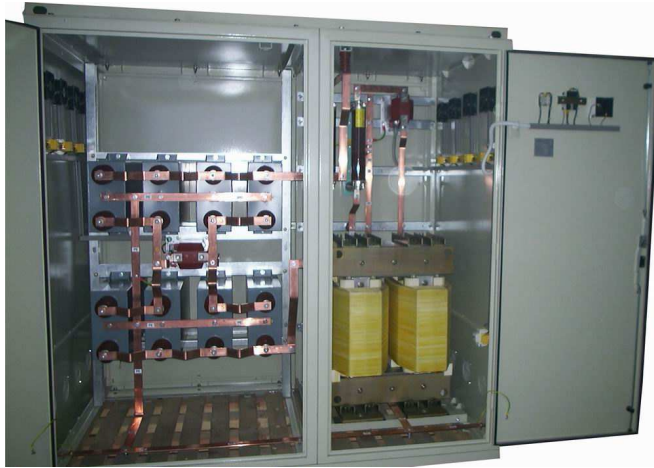
Jednofazowy filtr 3-ciej harmonicznej o napięciu znamionowym 6,6kV do kompensacji mocy biernej stacji prostownikowej. Producent: ELMA energia. Eksport do Australii
